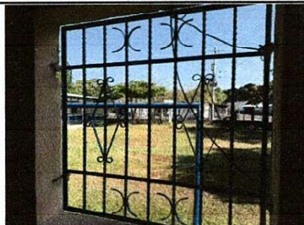
Foto 2: Mantenimientos de balcones de metal.
