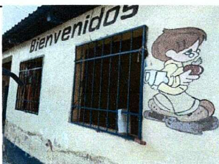
Foto 5: Fabricación e instalación de ventanas de PVC
