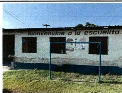
Foto 6: Repello en muros
