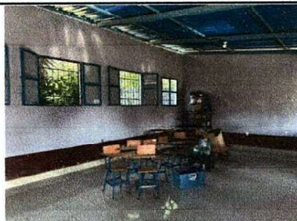
Foto 2: Pintura en muros interiores.
