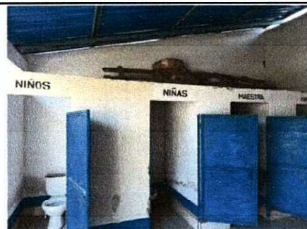
Foto 4: Sustitución de inodoros
