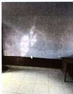
Foto1: Instalación de agua potable y colocación de pila.
