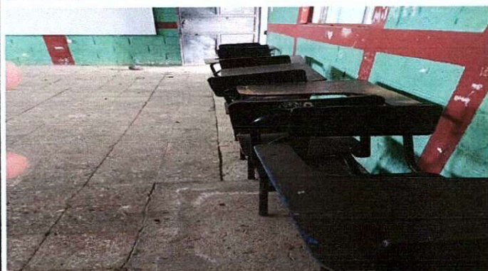
Foto 3: CAMBIO DE PISO AULAS
