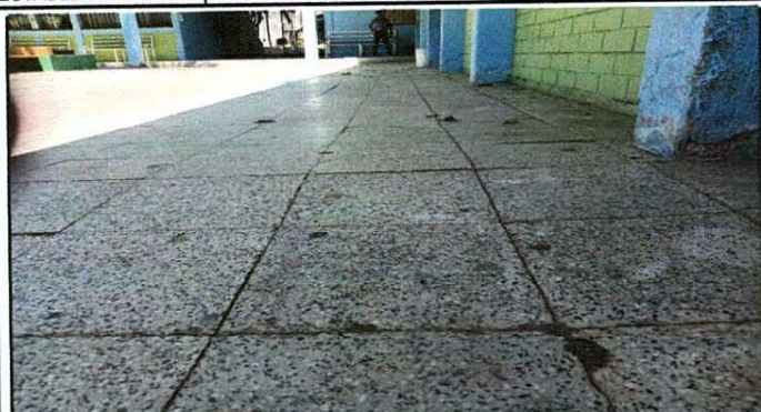
Foto 7: CAMBIO DE PISO CORREDOR 2
