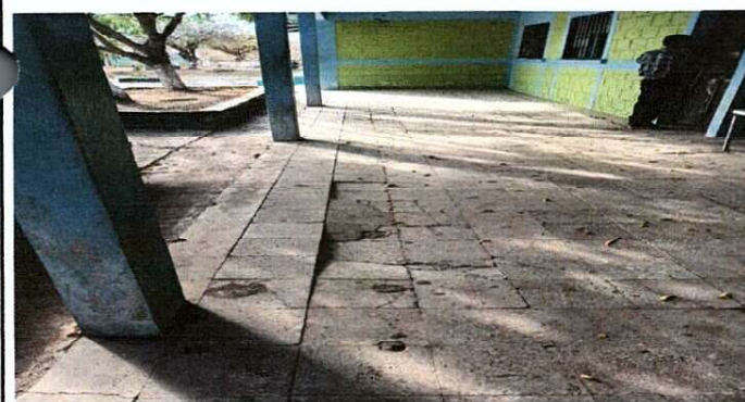
Foto 5: CAMBIO DE PISO CORREDOR 1
