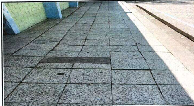
Foto 8: CAMBIO DE PISO CORREDOR 2
