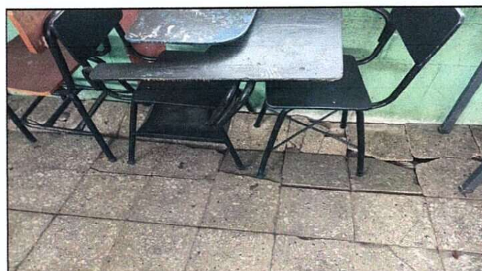
Foto 4: CAMBIO DE PISO AULAS
