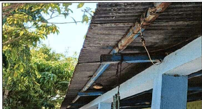
Foto 1: CAMBIO DE TECHO
