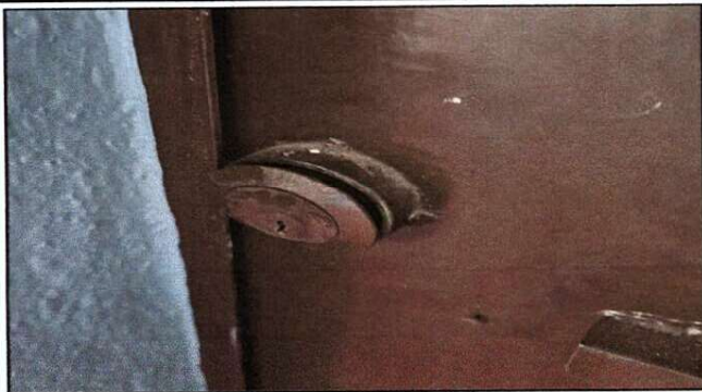
SUSTITUCION DE CHAPAS EN MAL ESTADO
