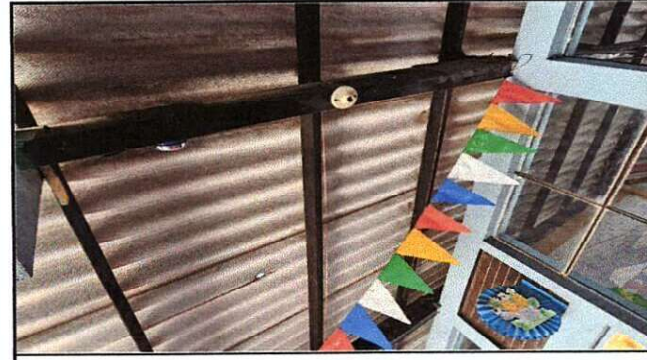
SUSTITUCION DE DUCTO ELECTRICO MAS ACCESORIOS Y DE FOCOS AHORRADORES
