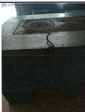
POLLETON AGRIETADO Y MAL ESTADO
