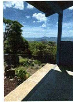
Foto 2: AREA DE PASILLO EN CONDICIONES PELIGROSA POR LA TOPOGRAFIA DEL TERRENO.
