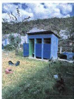
Foto 5: AREA DE BATERIA DE BAÑOS.
