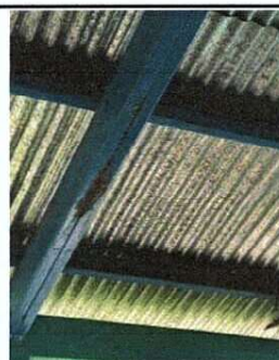
Foto 1: MANTENIMIENTO A ESTRUCTURA EN MAL ESTADO, GRAN PORCENTAJE CUENTA CON CORROSION.
