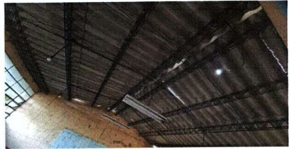
Foto 2: Sustitución de techo en mal estado
