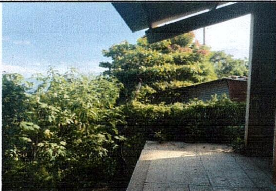
Foto 3: Sustrucción de malla por block, con cimientos y columnas parte de atrás del establecimiento.
