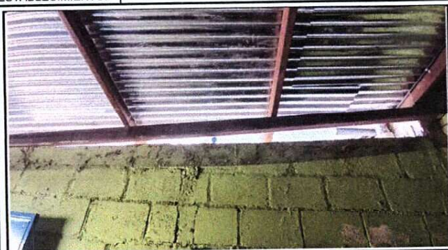
Foto 1: Remozamiento en paredes, aumento en la altura y selladas con la lámina para evitar el ingreso de roedores.
