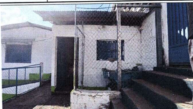
Foto 2: Rezamiento de ventana para mejorar la ventilación.
