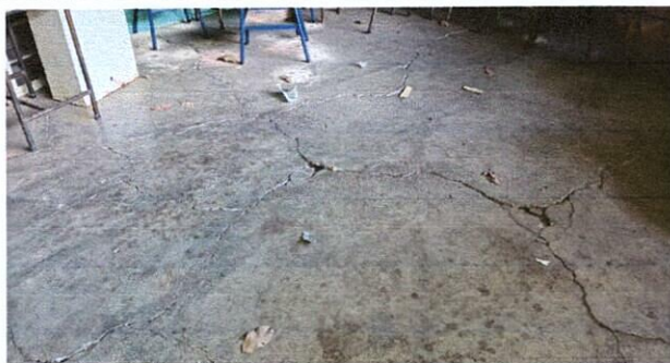
FOTO 6: MEJORAMIENTO DE PISO EN AULAS
