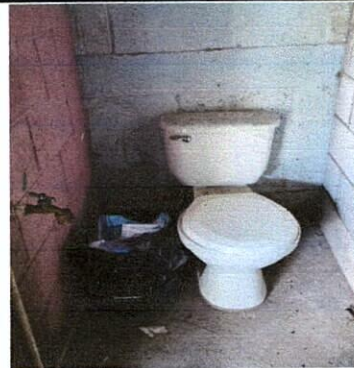
Foto 2: SUSTITUCION DE INODOROS
