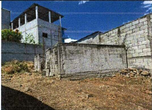
Foto1: Mejoramiento de area de cocina levanta de muros con block y columnas.
