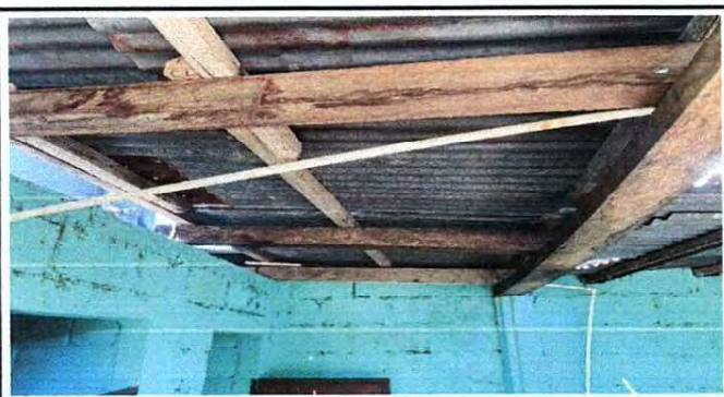
Foto 9: Cambio de techo en corredor
