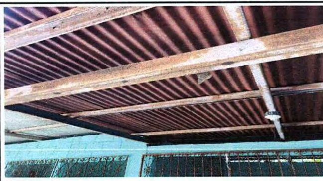
Foto 10: Cambio de techo en aula y corredor
