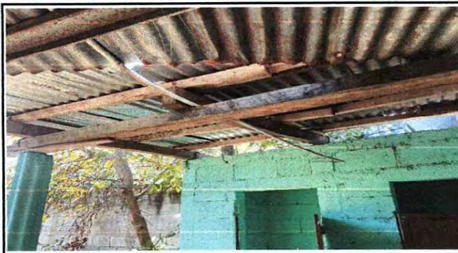
Foto 8: Ampliación de techo de cocina hasta cubrir los baños
