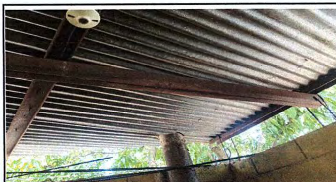
Foto 3: Fundición de concreto para soporte de techo
