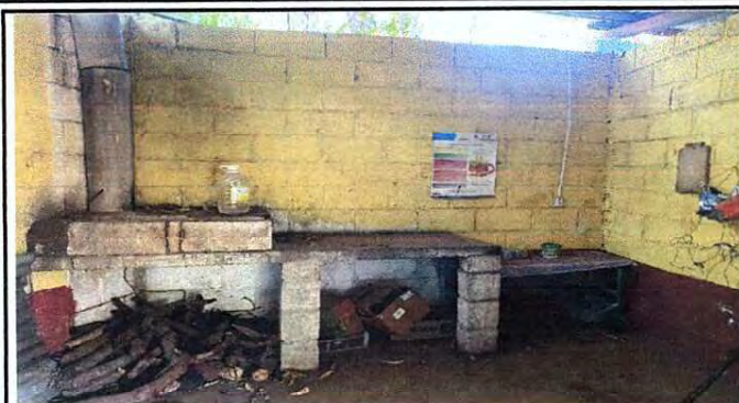
Foto 1: Sustrucción de hornilla con chimenea
