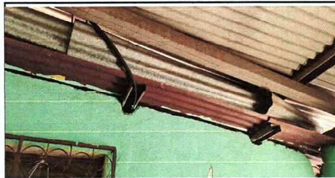
Foto 12: Cambio de estructura metálica y cubierta de lámina
