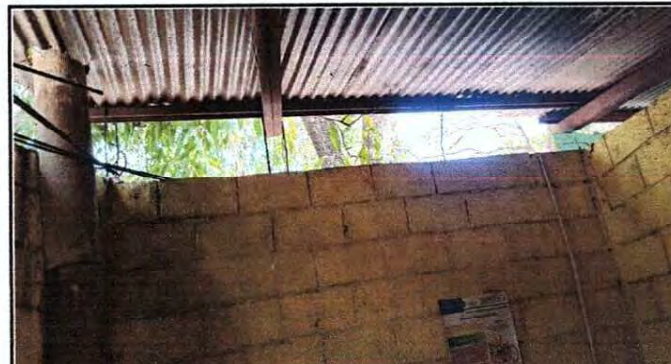
Foto 4: Levantado de paredes y cambio de techo
