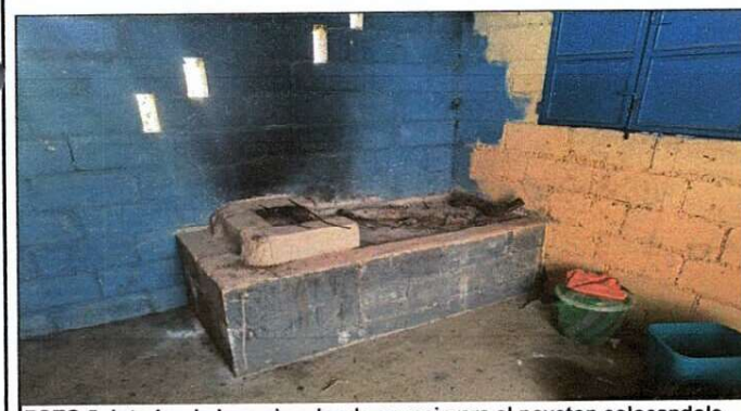
FOTO 5: Interior de la cocina donde se mejorará el poyeton colocándole azulejo con una plancha y su chimenea.
