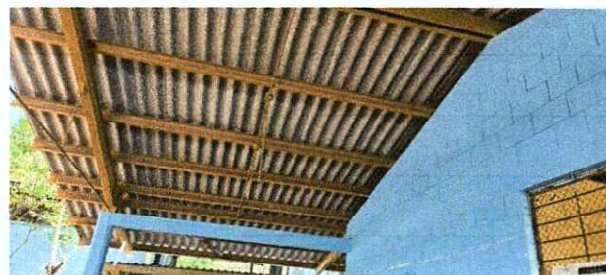
Foto 6: MEJORAMIENTO DE SISTEMA ELECTRICO
