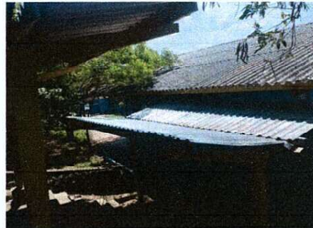
Foto 2: SUSTITUCIÓN DE TECHO DE DURALITA POR TECHO DE LÁMINA TROQUELADA EN MODULO DE AULAS
