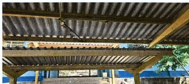
Foto 4: MEJORAMIENTO DE SISTEMA ELECTRICO (CAMBIO DE LAMPARAS)
