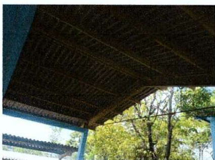
Foto 5: MEJORAMIENTO DE SISTEMA ELECTRICO
