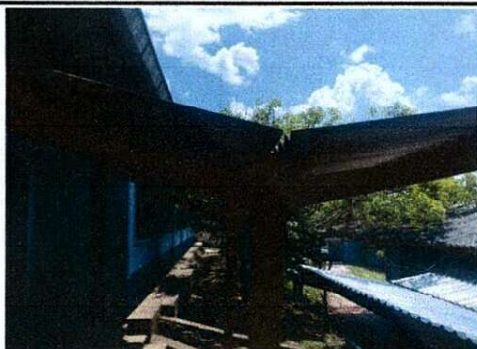
Foto 3: SUSTITUCIÓN DE CANAL METÁLICO Y BAJADAS DE AGUA PLUVIAL
