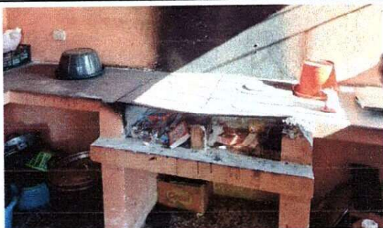
Foto 5: Mejoramiento de cocina. Sustitución de plancha y colocación de chimenea.
