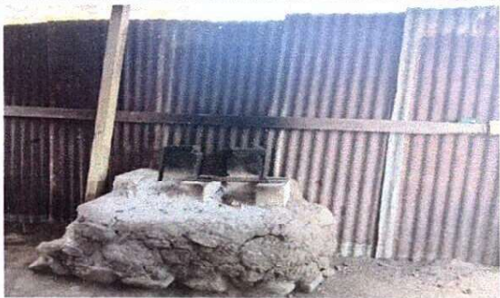
Foto 5: Parte interior de la cocina donde se mejorará el poyetón.
