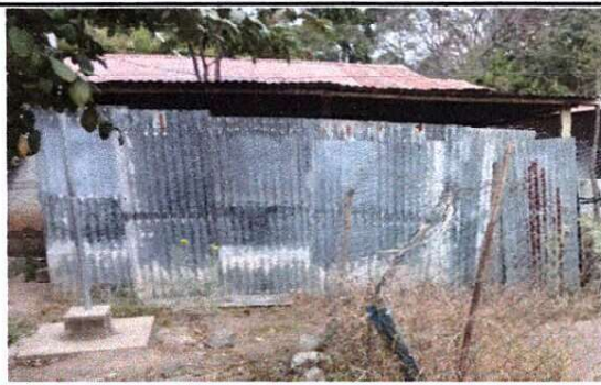
Foto 2: Parte exterior de la cocina donde se mejorará el techo.
