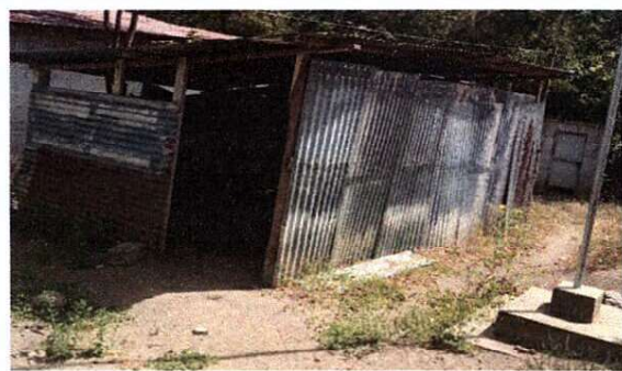
Foto 3: Mejoramiento de ingreso a la cocina.
