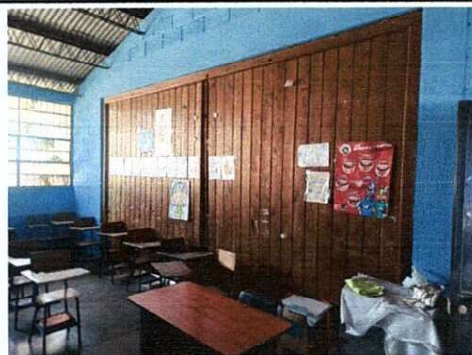
Foto 2: sustitución de pared provisional de madera
