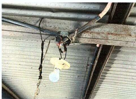
Foto 5: Sustitución de Sistema Elctrico del Establecimiento (Plafoneras)
