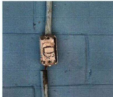
Foto 6: Sustitución de Sistema Elctrico del Establecimiento (Apagadores)
