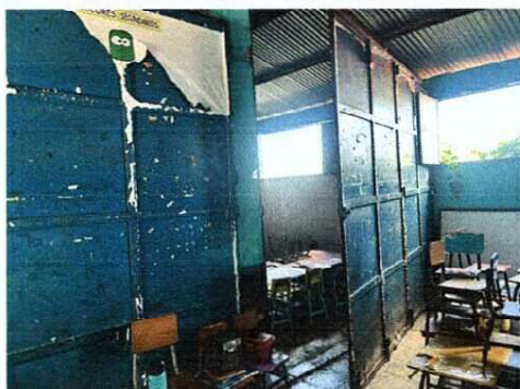
Foto 1: Sustitución de pared provisional de metal
