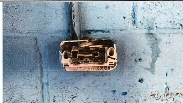
Foto 4: Sustitución del Sistema Elctrico del Establecimiento (Toma Corrientes)
