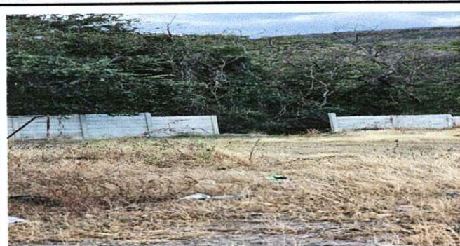
Segundo muro: también necesita refuerzo y levantado. Así también instalación de tubería para salida de agua en tiempo de invierno para que no colapse.
