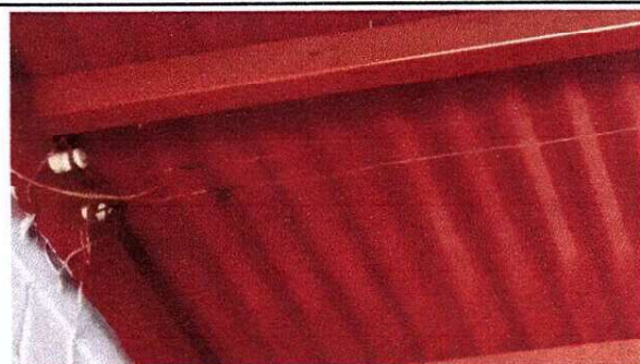
Foto 7: Mejoramiento de sistema eléctrico en aula, dirección, y cocina.
