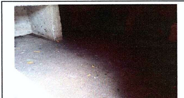
Foto 4: Se cambiará el piso de cemento por piso cerámico y repello de la cocina.
