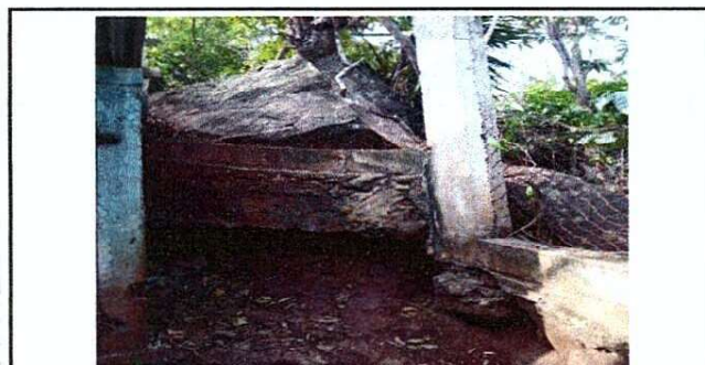
Foto 5: Mejoramiento de muro perimetral. Reforzamiento en área de riesgo (lado oeste).
