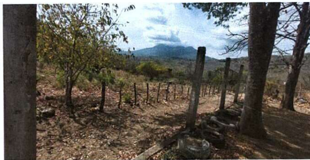
Foto 2: Gran parte de la malla se encuentra dañada.
