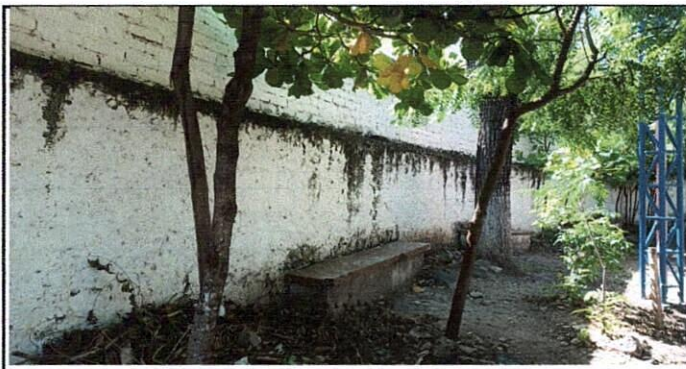
Foto 6: Lavado y pintado de muros.
