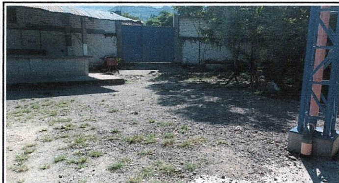
Foto 3: Fundir con concreto y electro malla
