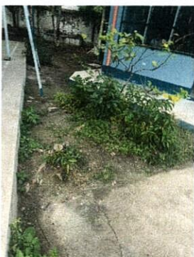
Foto 3: Entortado de Corredor afuera de la cocina
