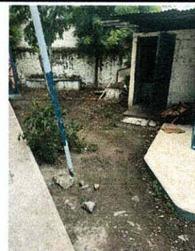
Foto 4: Sustitución de Puerta y laminas
