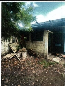
Foto 5: Instalación de luz electrica en cocina.
