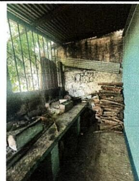
Foto 6: Levantado de paredes
