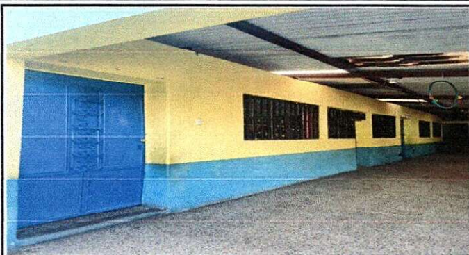
FOTO 1: Remozamiento con ventilación y altura de techo en aula
