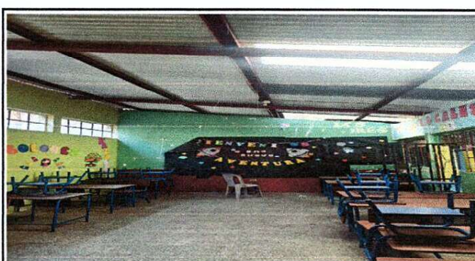
FOTO 6: Evidencia Aula donde se le subira de altura a las paredes.
