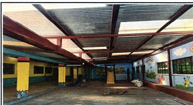
FOTO 3: Cubierta de Lamina con estructura metalica en patio a la cual se le subirá de altura.
