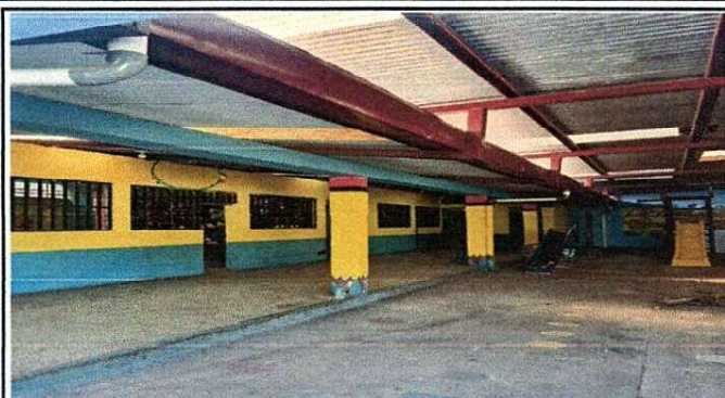
FOTO 2: Cubierta de Lamina en aulas con estructura metalica a la cual se le subira de altura.
