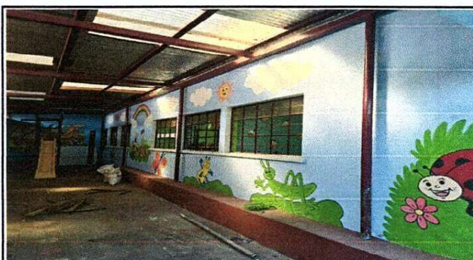
FOTO 4: Evidencia Techo Metalico en Patio donde se subira de altura a la estructura.
