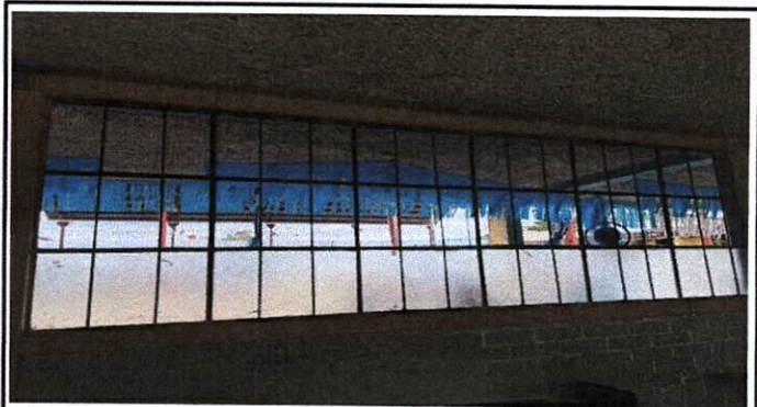
Foto3: Sustitución de ventana frontal de aulas, que por el tiempo se encuentran deterioradas
