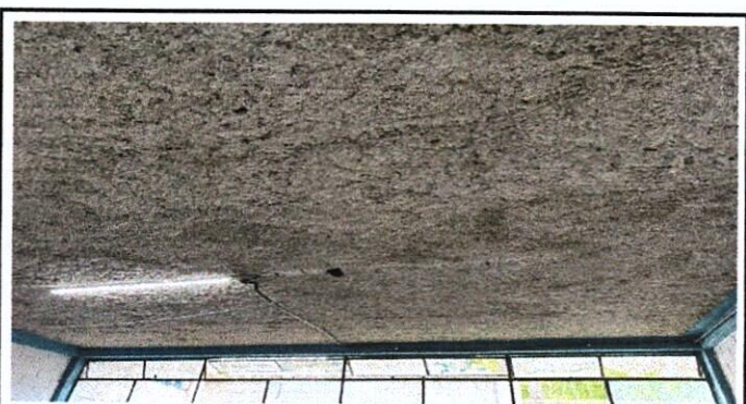
Foto 4: Mejoramiento de techo interno de aulas
