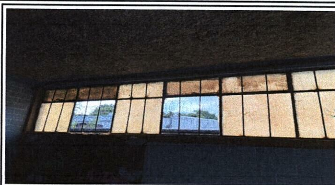
Foto2: Sustitución de ventana trasera de aulas, que por el tiempo se encuentran deterioradas
