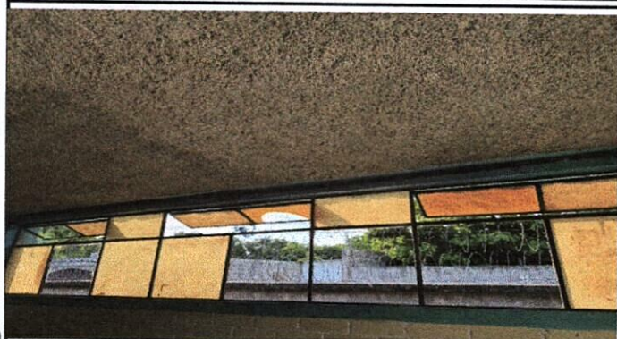
Foto1: Sustitución de ventana trasera de aulas, que por el tiempo se encuentran deterioradas
