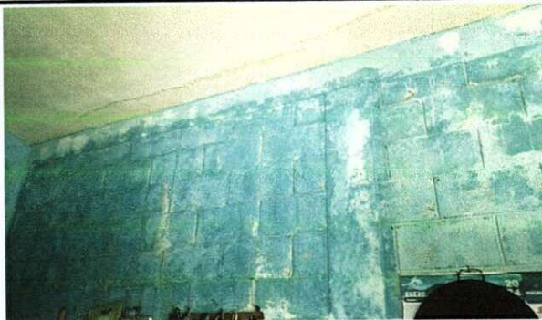
Foto 5: reparacion por filtracion de agua en area de losa
