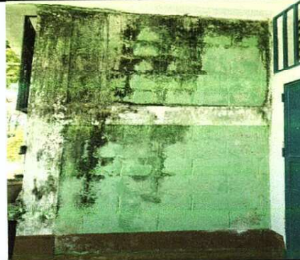
Foto 4: Reparacion por filtracion de agua en area de losa
