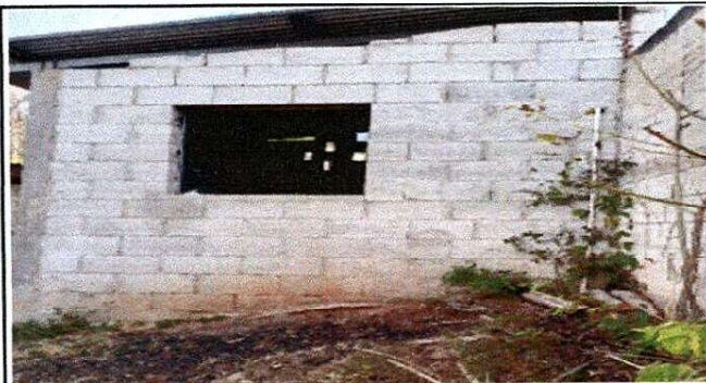
Foto 3: Instalación de ventana en área de cocina.
