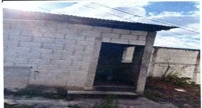
Foto 2: Instalación de puerta en el ingreso de la cocina para fortalecer la seguridad de la misma.
