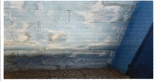
Foto 4: INSTALACION DE AZULEJO EN MODULO DE SANITARIOS
