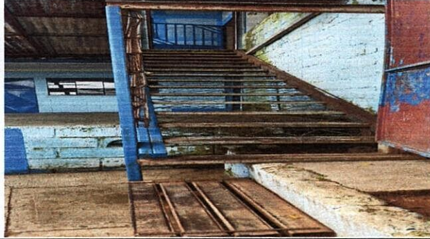
Foto 1: MEJORAMIENTO DE GRADAS CON CONCRETO ARMADO.
