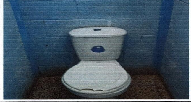
Foto 2: SUSTITUCION DE INODORO
