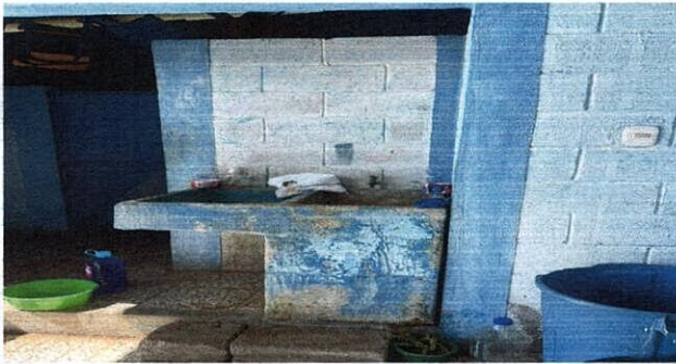
Foto 3: MEJORAMIENTO DE PILA, CONSTRUCCION DE TANQUE TIPO PILA FUNDIDO DE 1 LAVADERO
