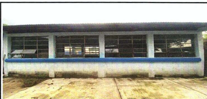
Foto 6: Instalación de balcones en aula en la parte frontal y trasera
