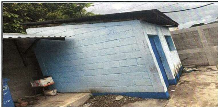
Foto 3: Elaboración de ventana tipo caseta en área de cocina.
