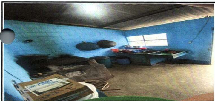
Foto 5: Mejoramiento de piso en cocina.
