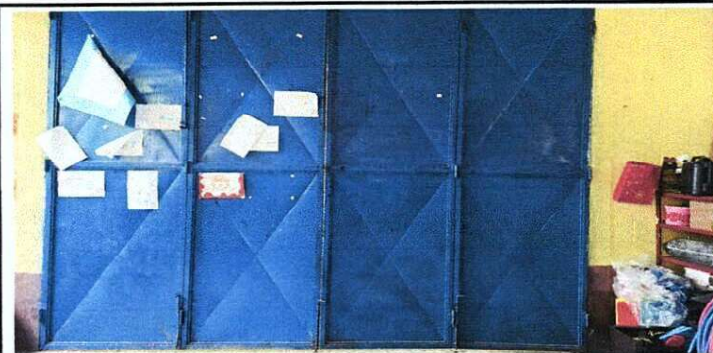
Foto 2: MEJORAMIENTO DE PUERTA INTERIOR DE AULAS
