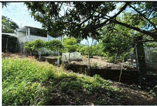
Foto 6: MEJORAMIENTO DE MURO PERIMETRAL
