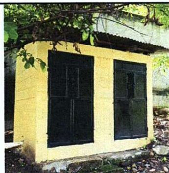
Foto 4: MEJORAMIENTO DE SERVICIOS SANITARIOS
