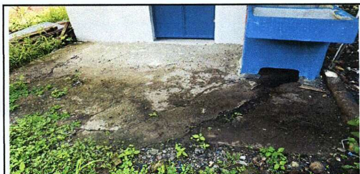
Foto 3: SUSTITUCIÓN DE PISO DE CONCRETO
