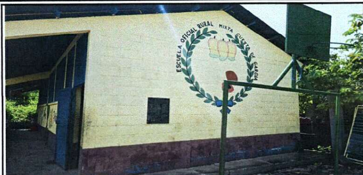
Foto 1: MEJORAMIENTO DE PINTURA EN MUROS
