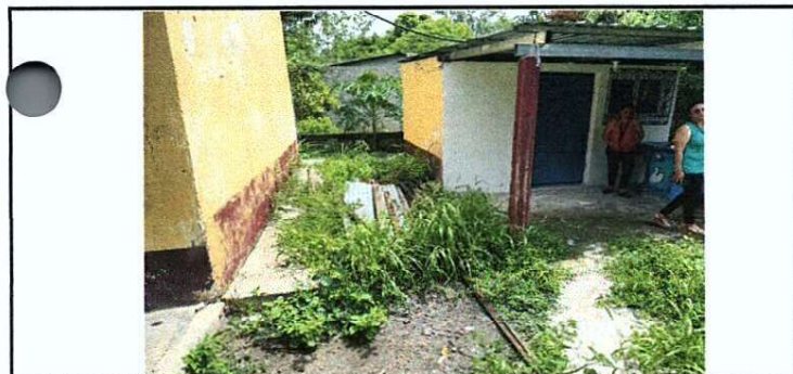
Foto 5: MEJORAMIENTO DE TECHO DE LÁMINA
