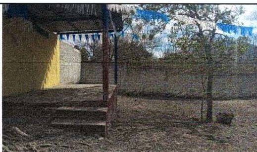
Foto 3: Escenario. Cimiento corrido tipo trapezoidal, fundición de torta de concreto con alisado de cemento.
