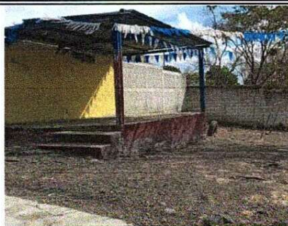
Foto 2: Escenario. Mejoramiento de techo y columnas de metal.
