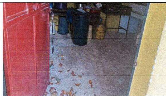
Foto 6: Cocina instalación de piso en cocina.
