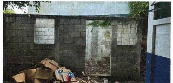
Foto 4: Mejoramiento de acabados en muros, cocina
