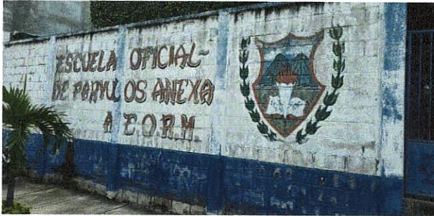
Foto1: Mejoramiento de pintura en muro perimetral
