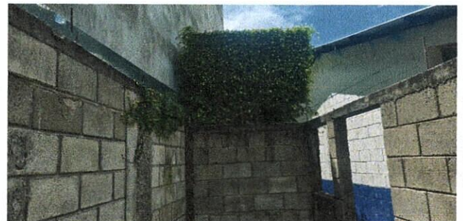
Foto 6: Mejoramiento de Techo de lamina alucin C-26, cocina
