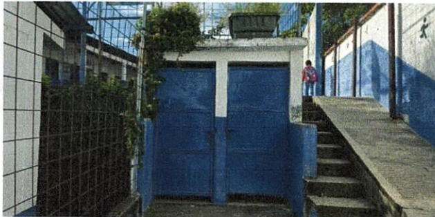
Foto 3: Sustitución de inodoros existentes
