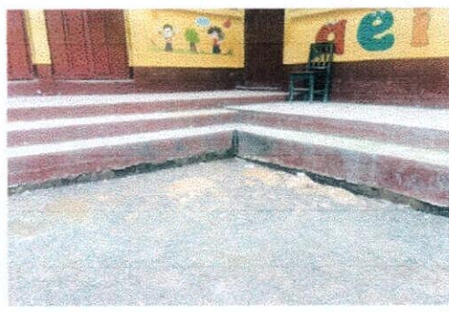
Foto 2: MEJORAMIENTO TORTA DE CONCRETO
