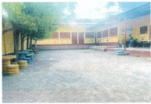
Foto 1: MEJORAMIENTO TORTA DE CONCRETO
