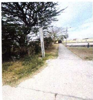
Foto1: Mejoramiento de red de drenaje hacia la calle principal
