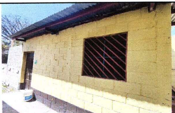
Foto 3: Fabricación de ventana en cocina de aluminio fish, mantenimiento de balcón, ventana-balcon en cocina, mejoramiento de techos.
