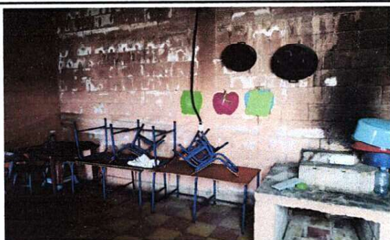
Foto 5: Mejoramiento de mueble de cocina y estufa rural completa.
