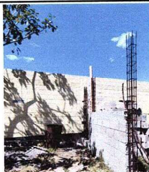
Foto 2: Mejoramiento de servicio sanitario
