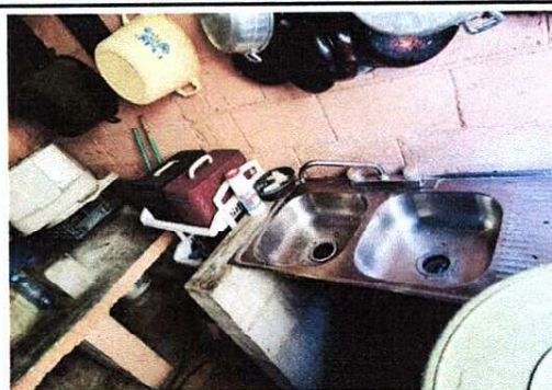
Foto 4: 1. Mejoramiento de lavatrastos en cocina
