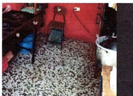
MEJORAMIENTO E INSTALACION DE PISO CERAMICO SEMI ANTIDESLIZANTE
