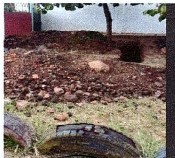
MEJORAMIENTO E INSTALACION DE TUBERIAS PARA RED DE DRENAJE
