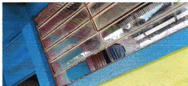
Sustitución de ventanas
