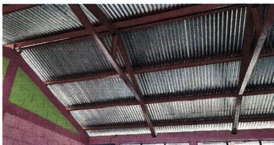
Sustitución de lámina canalada por lámina troquelada aluzinc calibre 26
