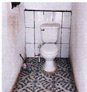
Foto1: Sustrucción de inodoros
