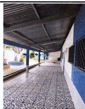
Foto 6: Instalacion de unidades de luz en pasillo
