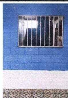
Foto 4: 1. Mejoramiento de aula y fabricación e instalación de puerta de metal.
