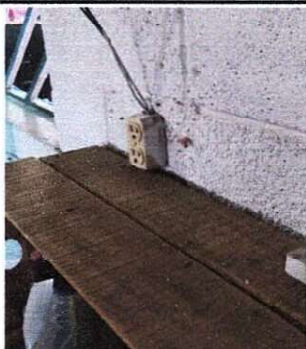
Foto 3: Instalación de unidades de fuerza (tomacorrientes)
