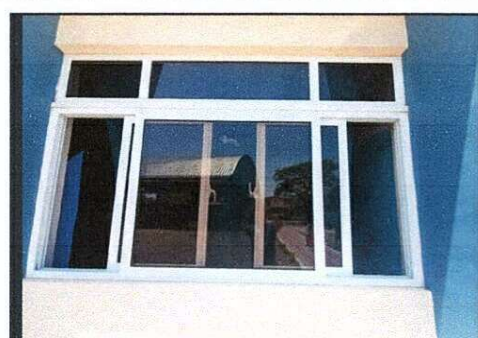
MEJORAMIENTO DE VENTANALES SUSTITUCION DE BALCONES
