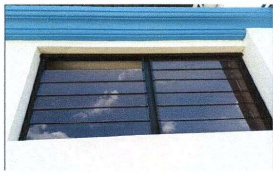
MEJORAMIENTO DE VENTANALES SUSTITUCION DE BALCONES
