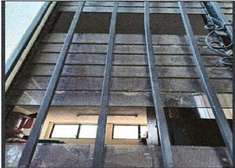
MEJORAMIENTO DE VENTANALES
