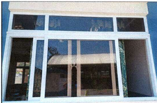
MEJORAMIENTO DE VENTANALES
