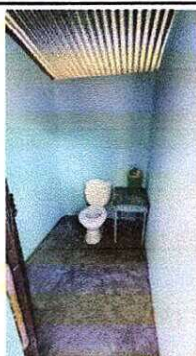
Foto 3: CAMBIO DE SANITARIOS Y COLOCACION DE PISO
