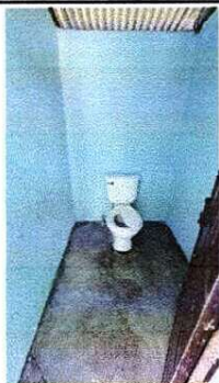
Foto1: MANTENIMIENTO DE ESTRUCTURA EN BAÑOS (PINTADO DE ESTRUCTURA, COSTANERAS)
