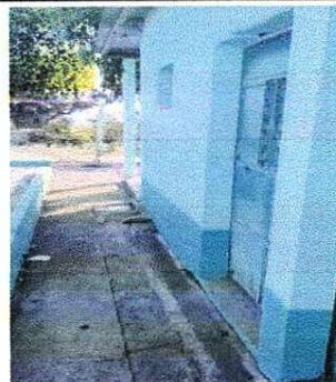
Foto 8: REPARACIÓN DE PUERTAS DE METAL (PINTURA)
