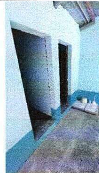
Foto 2: COLOCACION DE LAVAMANOS
