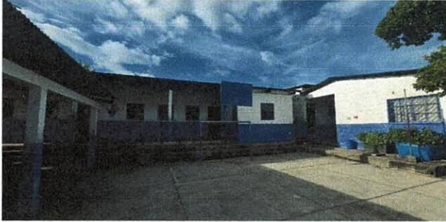
Foto1: Mejoramiento acabado de pintura en muros de Aulas
