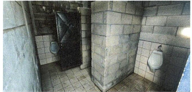
Foto 4: Sustitución de inodoros y mingitorios existentes
