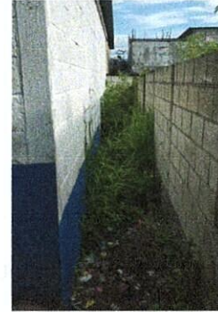
Foto 2: Mejoramiento torta de concreto
