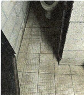
Foto 5: Mejoramiento de piso cerámico en baños
