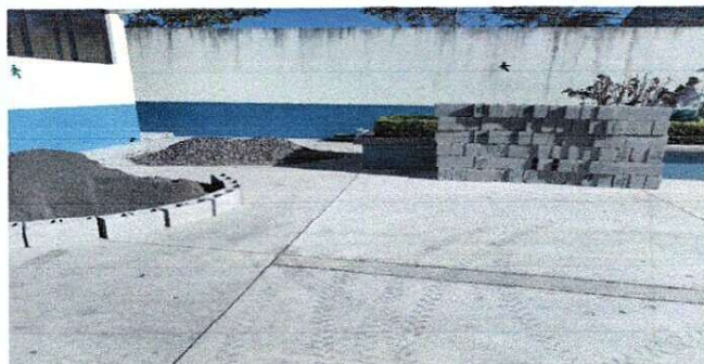
Foto 2: Ampliación y remodelación de cocina, instalación de pila
