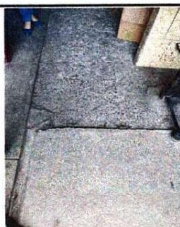
Foto 5: Mejoramiento de losas de concreto de piso en cocina
