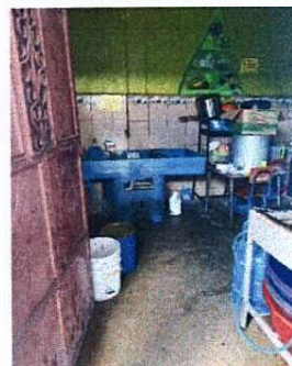
Foto 4: Mejoramiento de puerta y sustición de pila de concreto en cocina.
