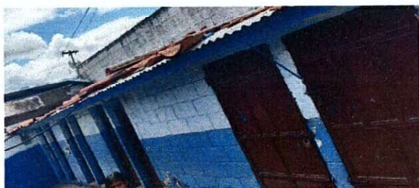
Foto 3: Mantenimiento y reparación de puertas de metal
