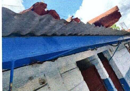
Foto 2: Mantenimiento de estructura de techo y sustitución de lamina por lámina aluzinc
