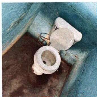
Foto1: Mejoramiento de piso por piso antideslizante más azulejo
