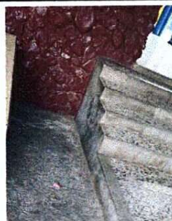
Foto 6: Mejoramiento de muro en cocina
