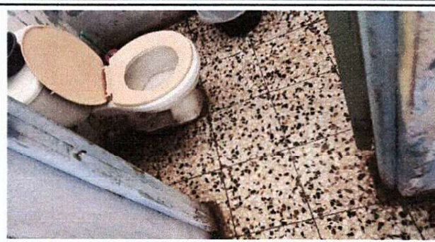
Foto 2: Mejoramiento de piso por piso antideslizante más azulejo
