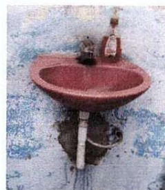
Foto 6: Mejoramiento de lavamanos
