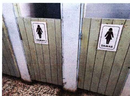
Foto 4: Mejoramiento de puertas en servicio sanitario
