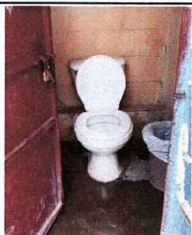
Foto 1: Sustrucción de inodoros
