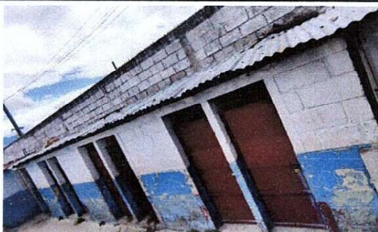
Foto 3: Mantenimiento y reparación de puertas de metal, sustrucción de lámina por lámina aluzinc calibre 26 y sustrucción de estructura de techo.
