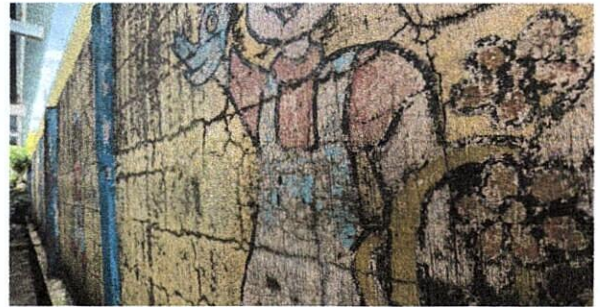
Foto 2: Mejoramiento del muro perimetral
