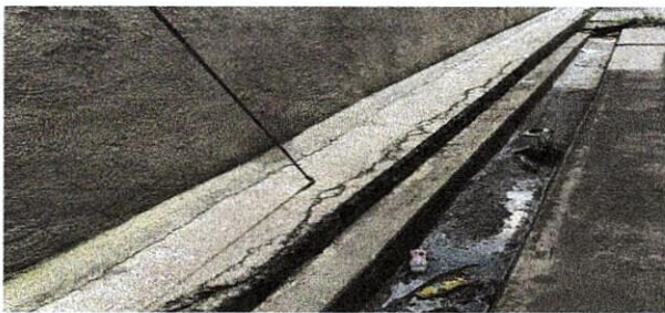
Foto 5: Sustitucion de tuberia de drenaje
