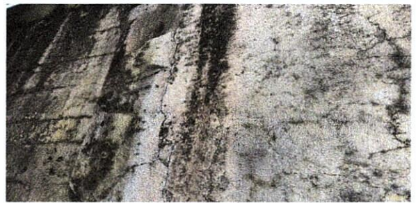
Foto 4: Mejoramiento del muro perimetral
