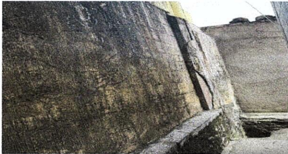
Foto1: Mejoramiento del muro perimetral
