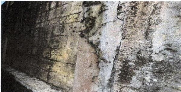
Foto 3: Mejoramiento del muro perimetral
