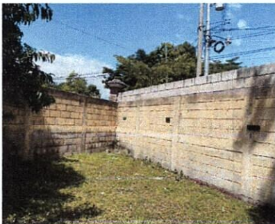
Foto 3: Mejoramiento Muro perimetral
