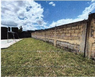
Foto1: Mejoramiento Muro perimetral
