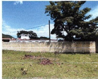
Foto 4: Mejoramiento Muro perimetral
