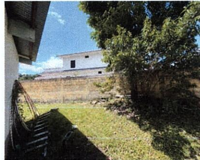
Foto 2: Mejoramiento Muro perimetral
