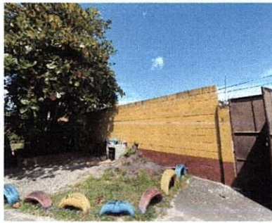
Foto 6: Instalación de Raso
