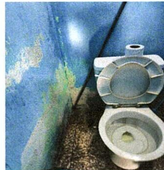
Sustitución de accesorios y todas las tazas de inodoros.
