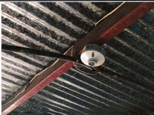
Sustitución de estructuras metálicas
