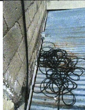
Reparación y/o sustitución del sistema eléctrico.
