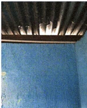
Sustitución de techos de lámina
