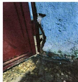
Sellado de grietas y fisuras en interiores y exteriores.
