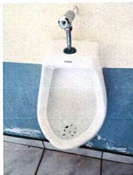
Foto 3: Cambio de Urinal por deterioro
