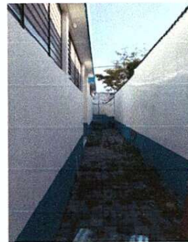
Foto 4: Mejoramiento de drenaje
