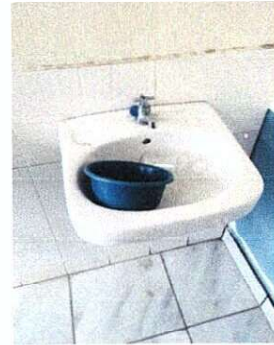
Foto 2: Cambio de lavamano por deterioro
