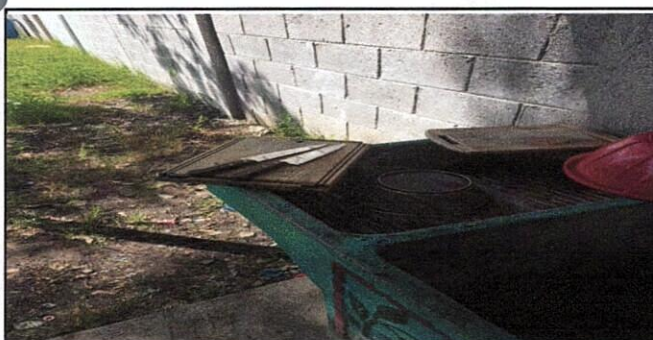
FOTO 5: SUSTITUCIÓN DE RED DE DRENAJE TAPADO
