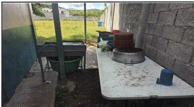
FOTO 1: LEVANTADO EN MURO
