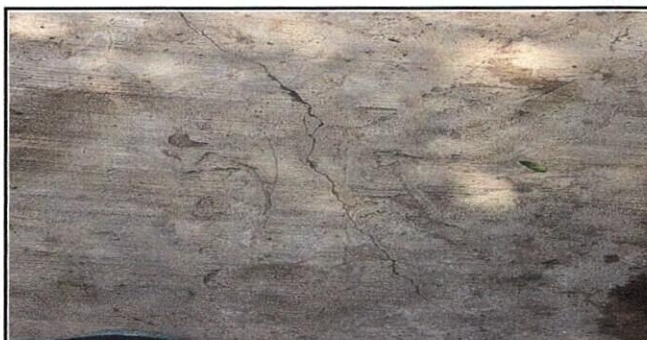
FOTO 6: SUSTITUCIÓN TORTA DE CEMENTO PICADA Y CON GRIETAS POR CERÁMICO
