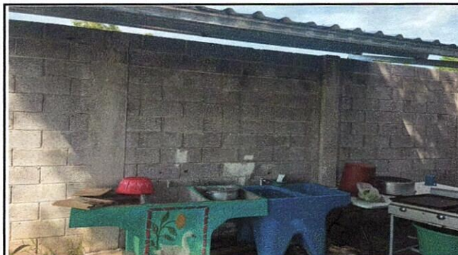
FOTO 2: SUSTITUCIÓN DE TECHO
