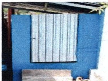
Foto 3: Sustitución de puerta
