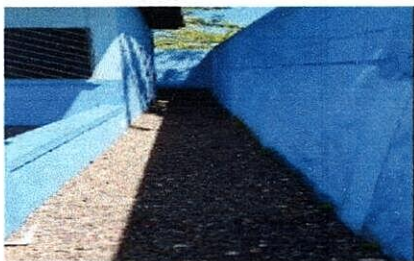
Foto 5: Reparación de planchas de concreto de patio
