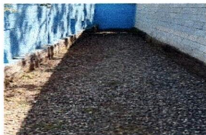
Foto 6: Reparación de planchas de concreto de patio
