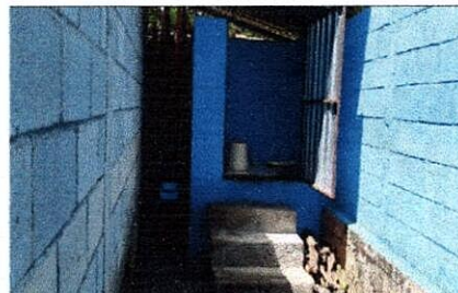
Foto 4: Sustitución de inodoro
