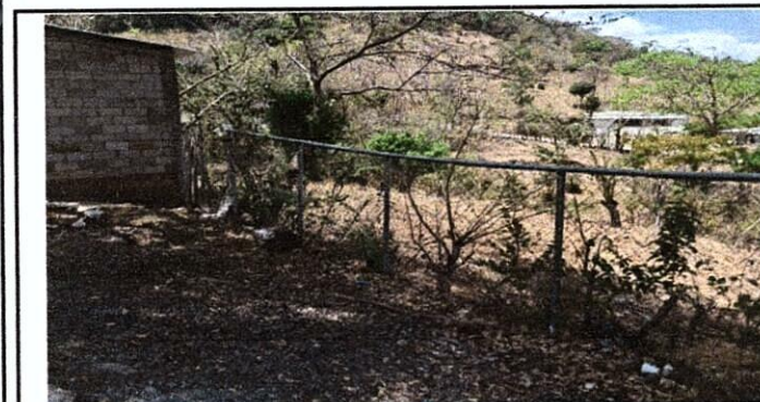
FOTO 5: MEJORAMIENTO Y COLOCACIÓN DE CINTA ROMPE VIENTOS PARA MALLA PERIMETRAL
