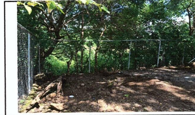
FOTO 6: MEJORAMIENTO Y COMPACTACION DE PIEDRIN Y MESAS DE DESCANSO CON SUS BANCAS. / MEJORAMIENTO DE BANCAS DE CONCRETO EN AREA DE PATIO
