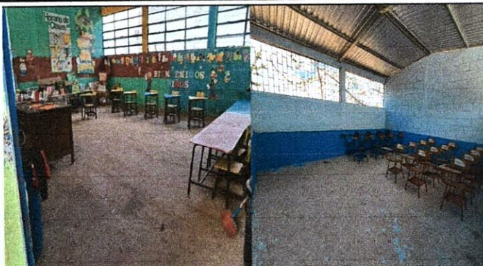
FOTO 1: MEJORAMIENTO DE PISO CERAMICO EN 3 ALULAS
